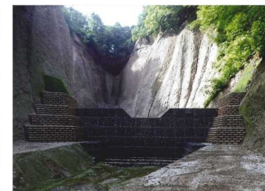
【治山：溪間工（治山ダム）】
