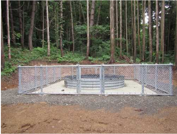
【地すべり防止工】
