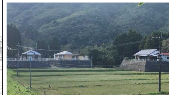
災害危険区域における 宅地の嵩上げ
