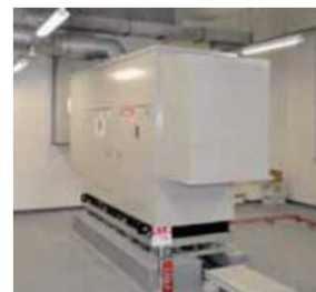
非常用発電設備のイメージ
