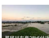
那珂川右岸28k6付近
