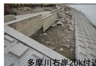
多摩川右岸20k付近
