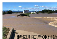
越辺川右岸0k付近
