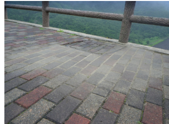
ダム本体左岸歩道のインターロッキングブロックを補修しました。
