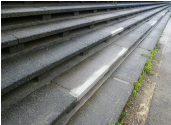
七ヶ宿ダム自然休養公園内の船着き場階段護岸を補修しました。
