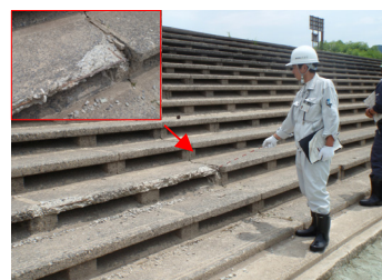
七ヶ宿ダム自然休養公園内の船着き場階段護岸を補修しました。
