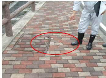
ダム本体左岸歩道のインターロッキングブロックを補修しました。
