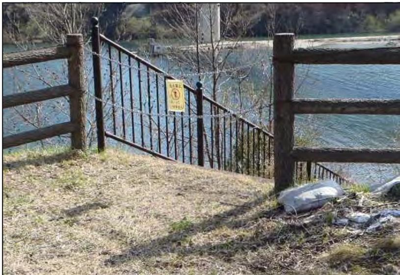
急な階段への立入防止チェーンの隙間が大きい。小さな子供がくぐると、急な階段になる。
