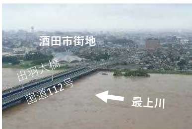
【国】最上川3.0km付近(出水の状況)
