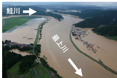
【国】最上川44.3km付近(出水の状況)
