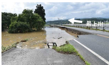
【国】最上川44.3km付近(堤防欠損状況)
