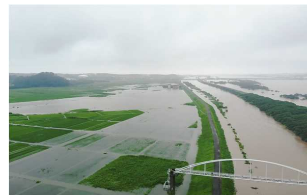
《最上川5.0k付近の浸水被害状況》
