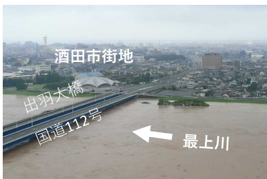
【国】最上川3.0km付近(出水の状況)
