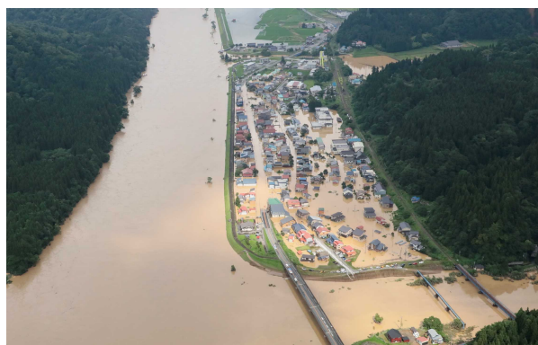
《最上川40.0k付近の浸水被害状況》
