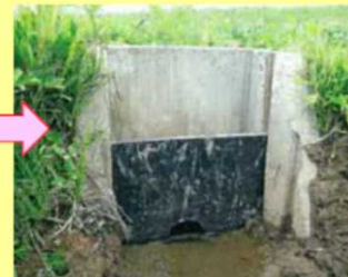
水戸板設置状況
