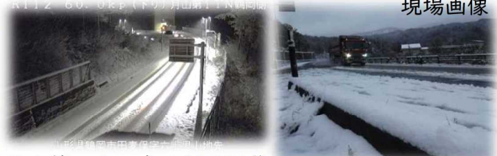
月山第一トンネルCCTV画像
