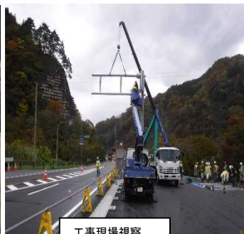
工事現場視察
