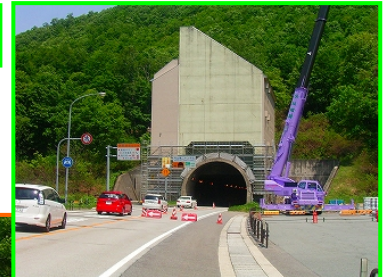
トンネル換気塔
