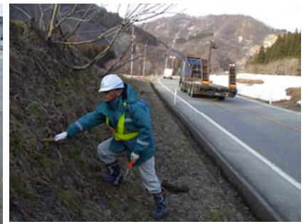
斜面の点検状況(浮き石確認)
