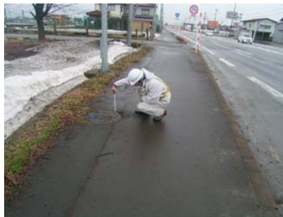
歩道の点検状況(段差確認)
