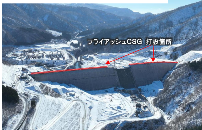
■規格外フライアッシュを使用した箇所(下流面から見た斜め写真)
