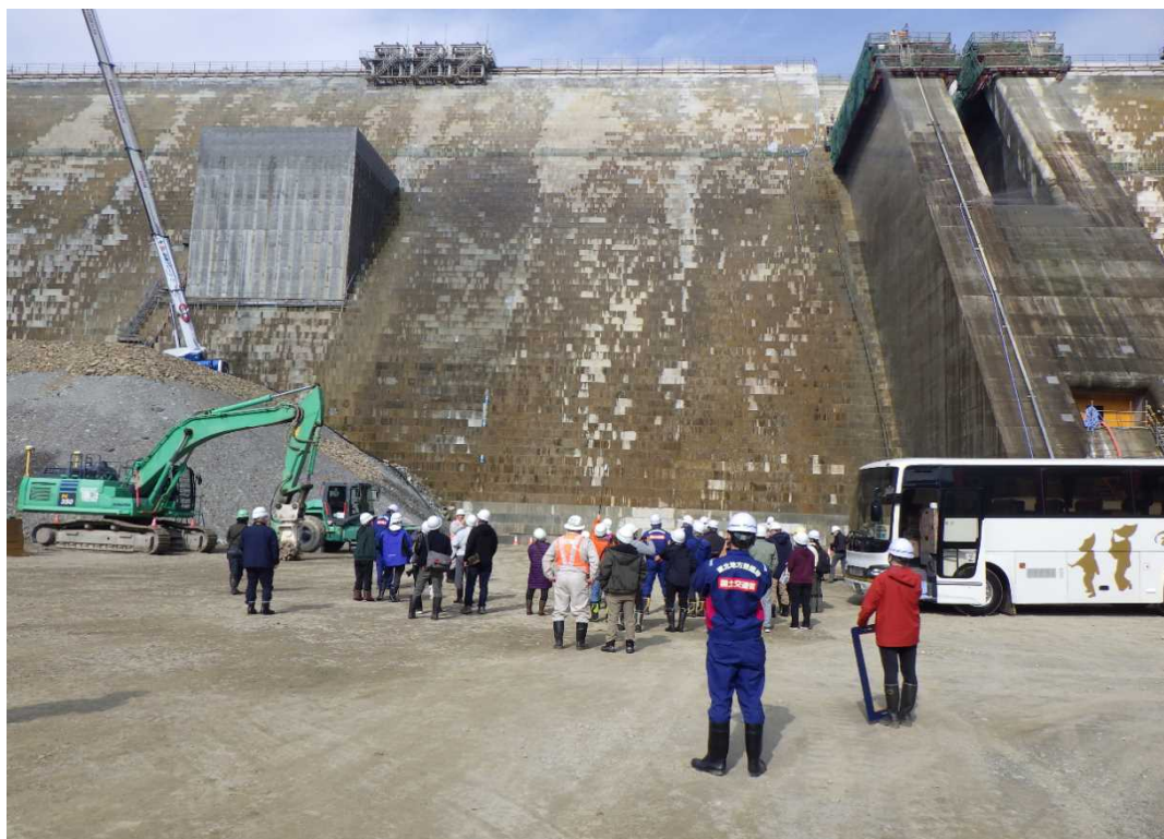
堤体上流側(取水塔下)からダム本体の見学
