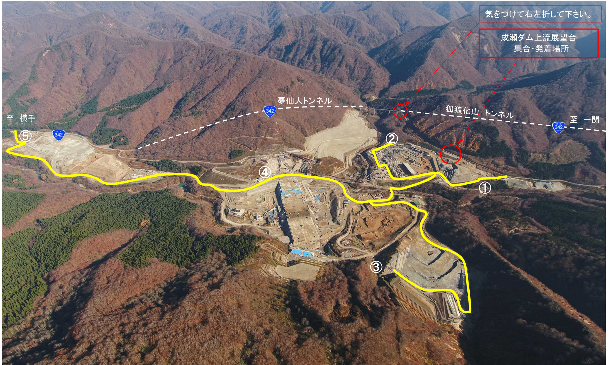
①上流ゲート → ②プラント群内(中央操作室Uターン) →③原石山展望台 →④堤体右岸EL480通過 →⑤下流ゲート
