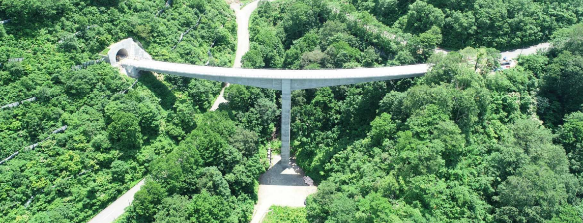
橋梁延長：L=約156m
