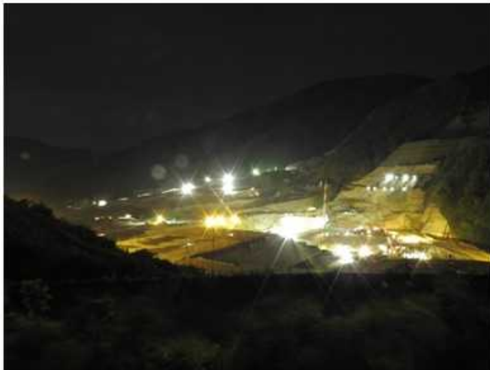
右岸展望台から見た堤体
