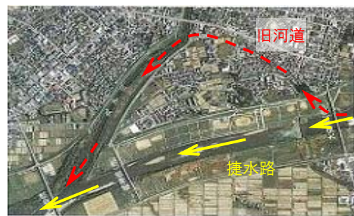
大曲捷水路完成後(平成 11 年)
