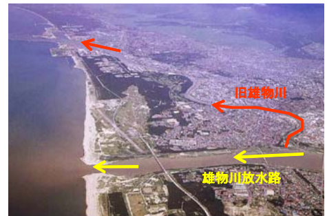
図 2.2-3 雄物川放水路
