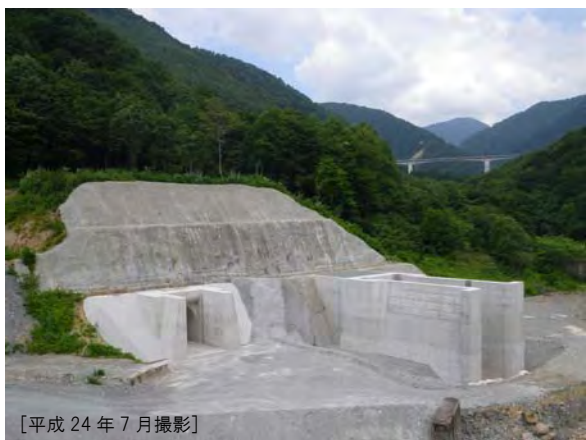
転流工施工状況
