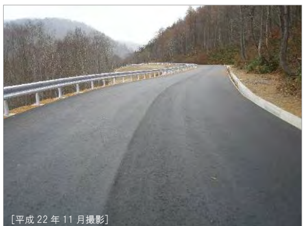
上流迂回道路
