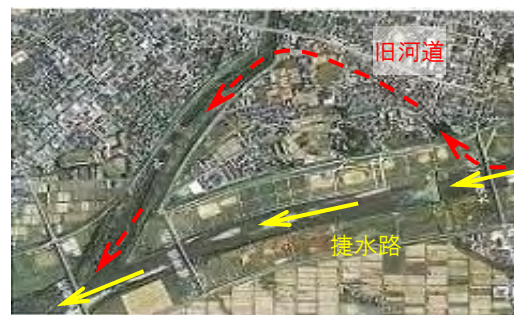
大曲捷水路完成後(平成 11 年)
