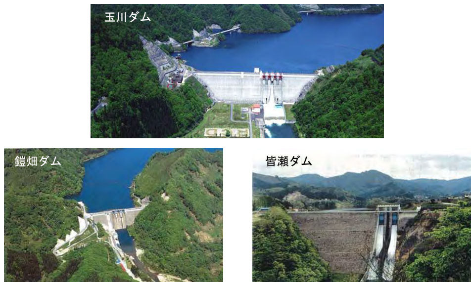
図 2.2-7 玉川ダム及び鎧端ダム、皆瀬ダムの全景
