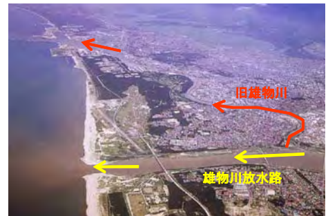
図 2.2-3 雄物川放水路
