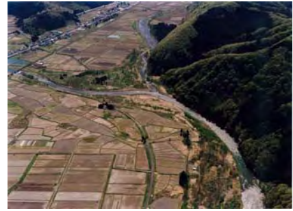
国管理上流端付近(役内川合流点付近)
