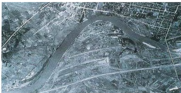
大曲捷水路改修着工前(昭和 36 年)
