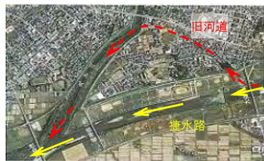
大曲捷水路完成後(平成 11 年)
