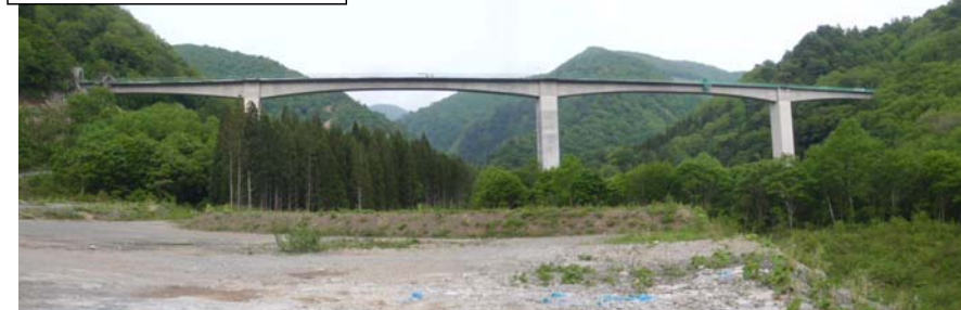
国道付替 (1号橋) 施工状況
