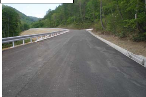
現道接続区間施工状況
