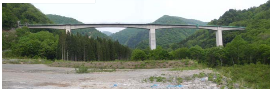
国道付替 (1号橋) 施工状況
