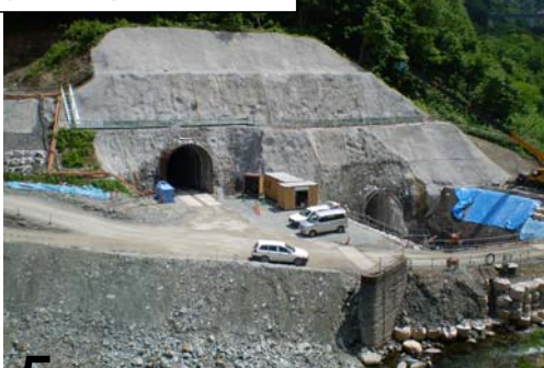
転流工 (呑口) 施工状況
