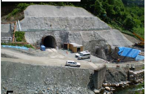
転流工 (呑口) 施工状況
