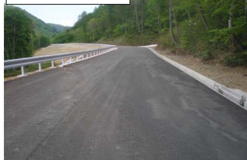
現道接続区間施工状況
