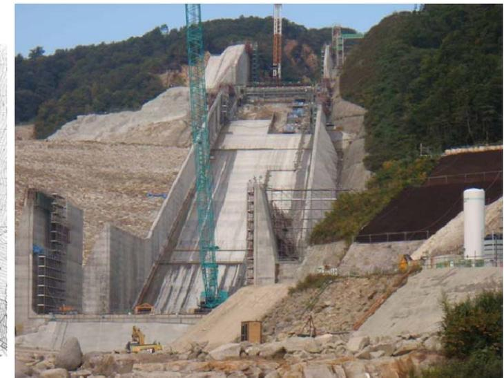
洪水吐コンクリートの打設(他ダム事例)
