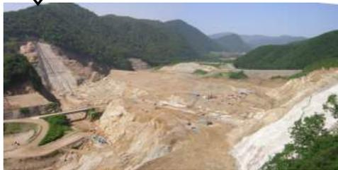
表層の風化部を取り除き、基礎岩盤として十分な強度を有する良好な岩盤が得られるまで掘削する工事
