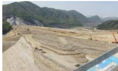
ロック材、コア材等を盛立てて、ダム堤体を築造する工事
