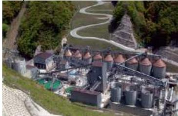
工事により発生した濁水を浄化処理する設備や、ダムのコンクリートを製造する設備などを設置する工事
