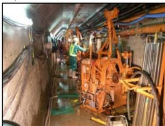
基礎岩盤の割れ目からの漏水を防ぐため、グラウトを注入して止水処理する工事
