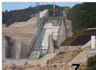
ダムの放流設備である洪水吐きのコンクリートを打設する工事
