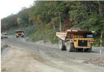
盛立材料や資機材、掘削により発生した土を運ぶための工事用の道路を設置する工事
