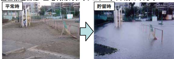
雨水貯留施設の例(荏田南小学校、神奈川県横浜市都筑区)
