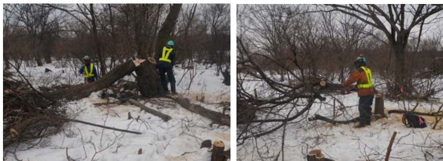
雄物川下流の中州における樹木の伐採状況写真
