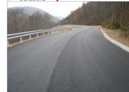
上流迂回路施工状況
