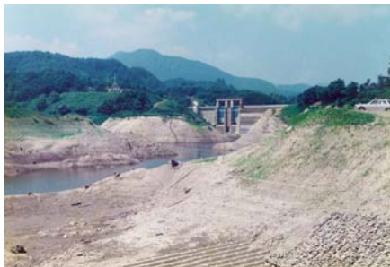
底をついた皆瀬ダム 皆瀬ダム(湯沢市皆瀬) H6. 8. 8撮影
