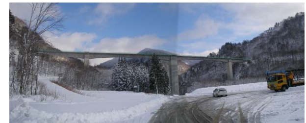
1号橋施工状況
