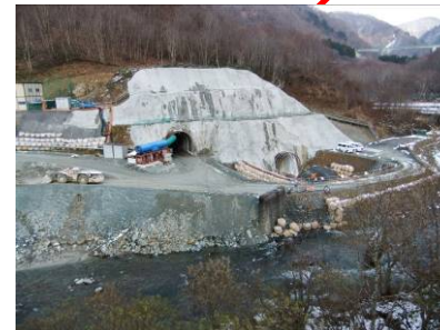
転流工(呑口)施工状況
