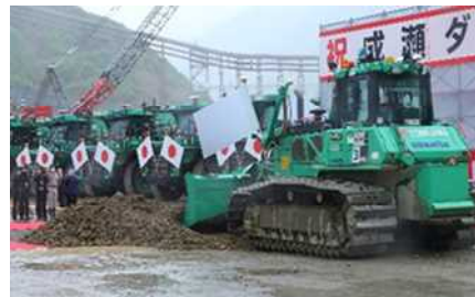
無人重機によるCSG敷き均し
