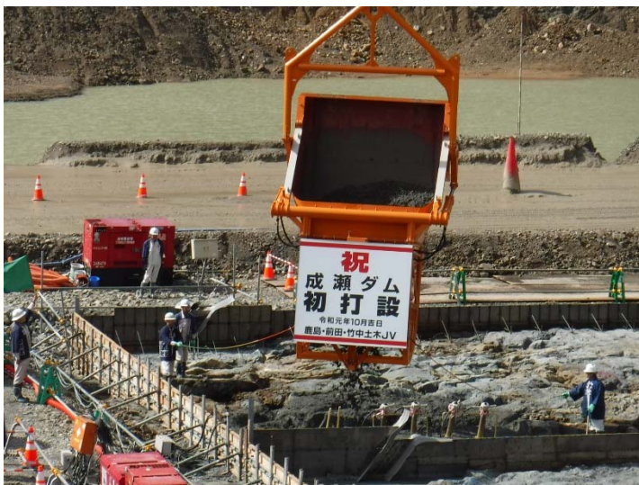
コンクリート初打設の瞬間
