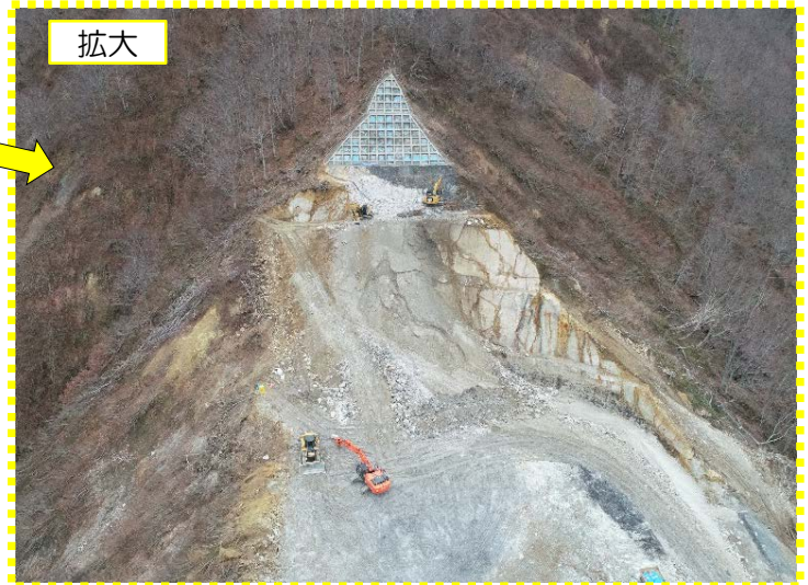
原石山を掘削している状況
