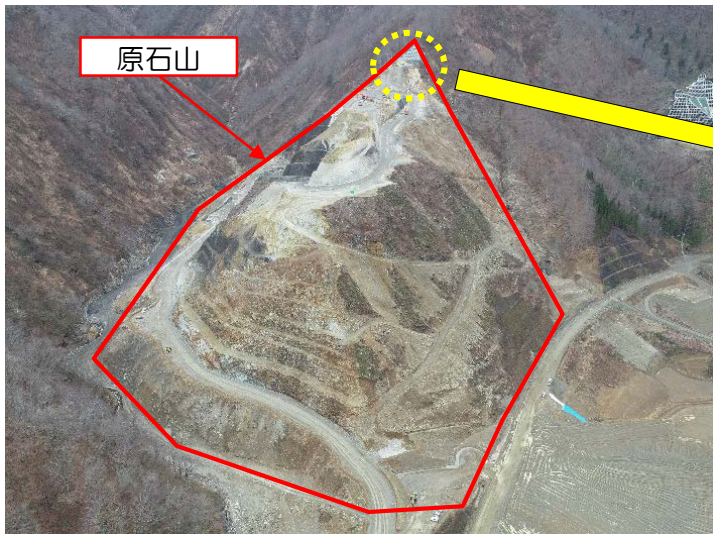
工事箇所（原石山全景）
