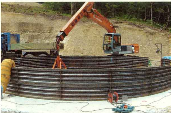
(P2深礎杭掘削状況)
