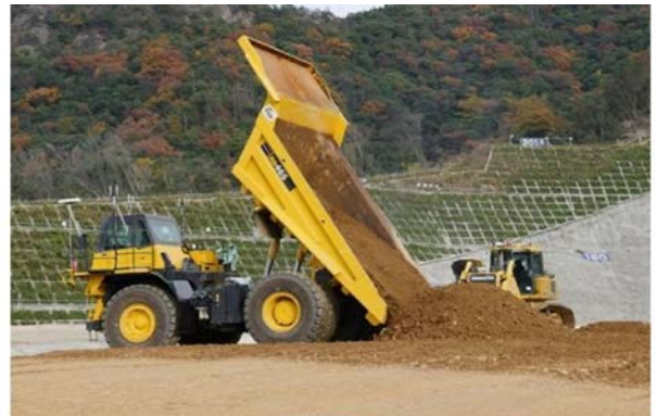
自動ダンプトラックと自動ブルドーザーの連動作業状況 (他ダムの事例)
