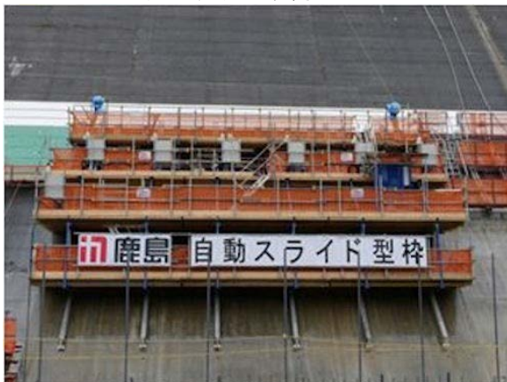
自動スライド型枠施工状況 (他ダムの事例)
