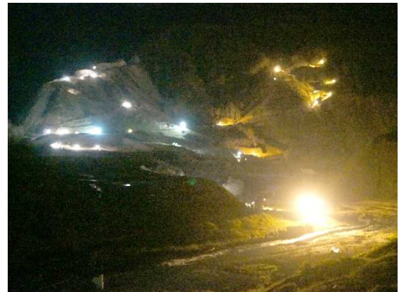
平成29年の夜間工事の様子
