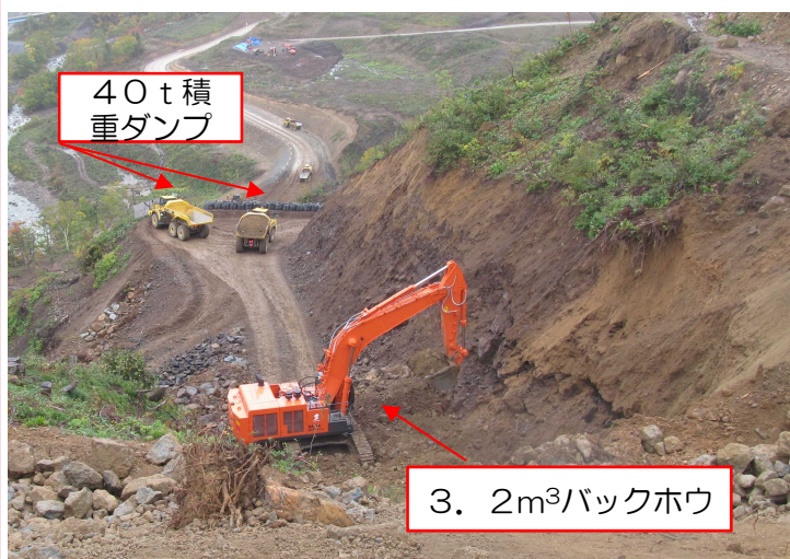
掘削した土砂の積込状況
