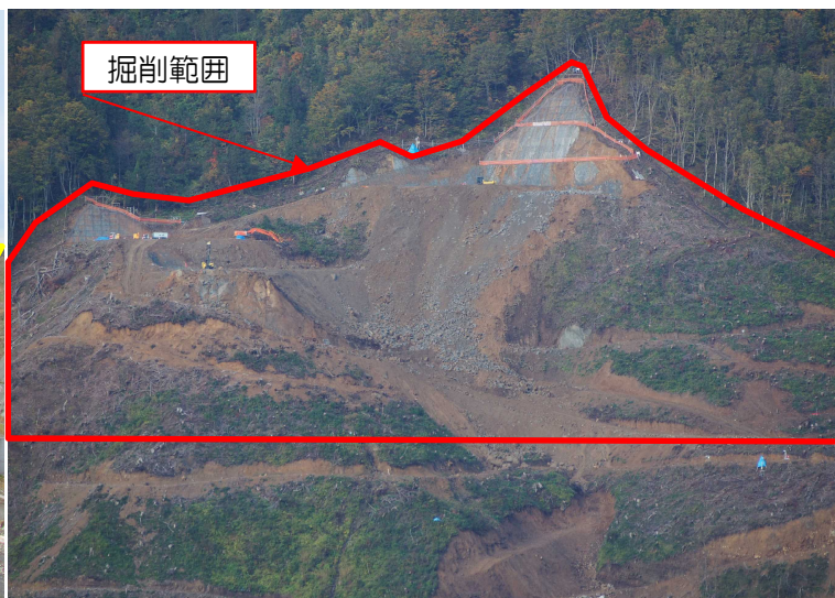
法面を掘削している状況
