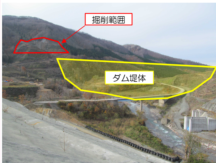
工事箇所（ダム堤体左岸側全景）
