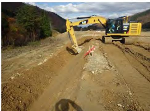
46 t級の重ダンプを走行させるための工事用道路を造成しています
