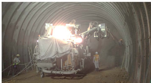
③腕のついた機械でアーチ型の鋼材を設置して、掘ったトンネルが崩れないように支えます。その後コンクリートを吹き付けて固めます。
