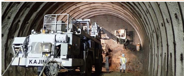
①岩盤に穴を掘って爆薬を入れて発破し、岩を砕きます。 はっば
