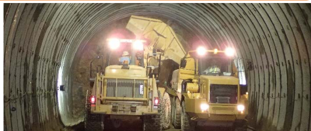
②発破で砕いた岩を大型ダンプトラックに積み込み、トンネルの外に運びます。 はっば
