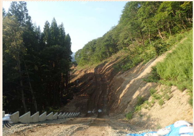
▲写真① 工事前の状況
