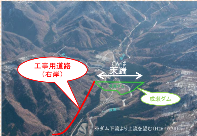
▲ 今回紹介する現場箇所
