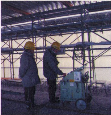
(横締め作業状況・・・写真左は緊張用の油圧ポンプ 写真右は緊張ジャッキです)
