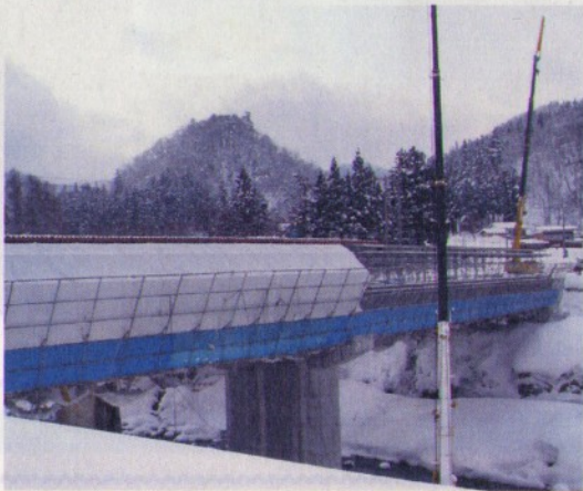
(仮囲い施工状況)
