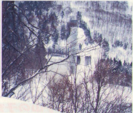
(トンネル終点側坑口から1号橋下部工を望む)
