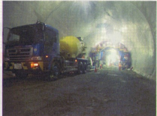
(覆工コンクリート施工状況)
