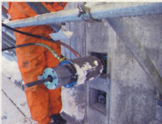
(横締め作業状況・・・写真左は緊張用の油圧ポンプ 写真右は緊張ジャッキです)
