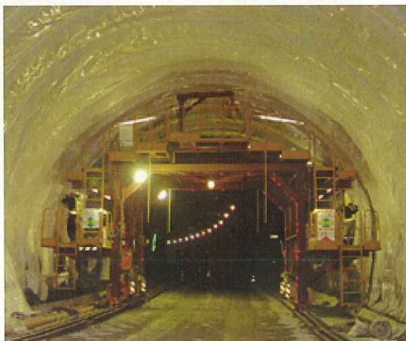
(1号トンネル覆工作業状況)
