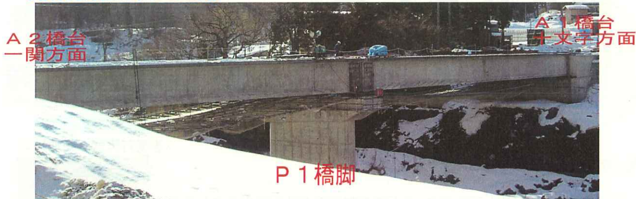
(肴沢橋主桁完成)
