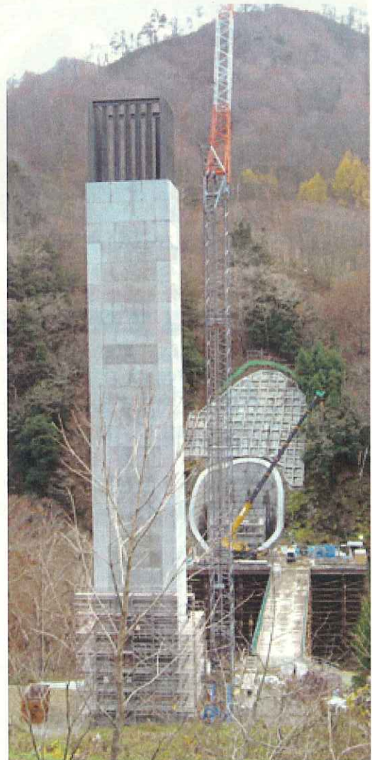
(1号橋下部工P2完成)
