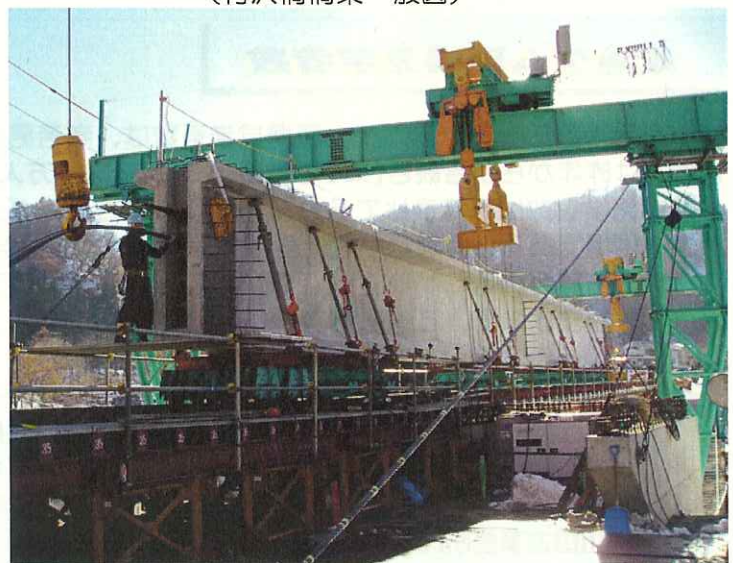
(主桁組立状況)
