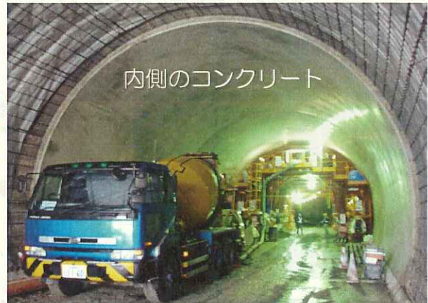
（覆工作業状況）
