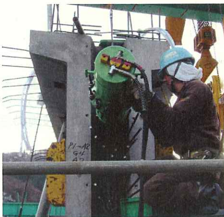
(主桁緊張状況)
