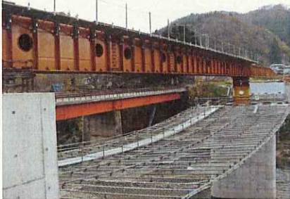
(架設桁設置状況)
