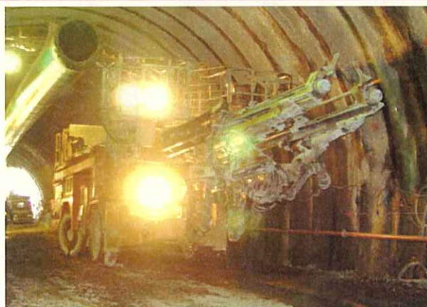
① 2ブームホイールジャンボ (火薬をつめる孔を掘る機械)
