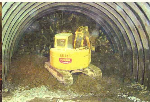
③ バックホウ掘削状況
