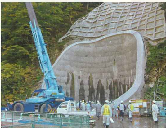
（事故防止対策委員会 1号橋下部工P3視察）
