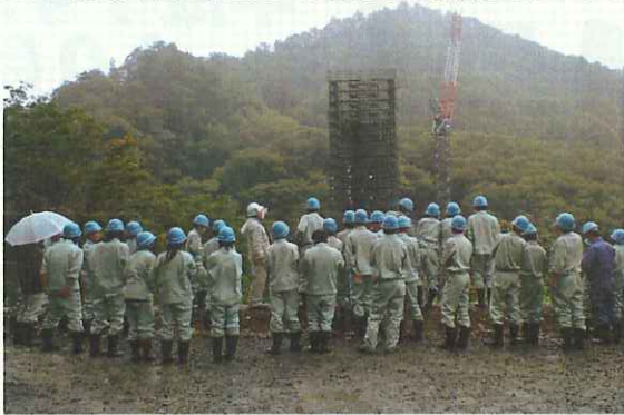
(1号橋下部工工事を高台から説明)
