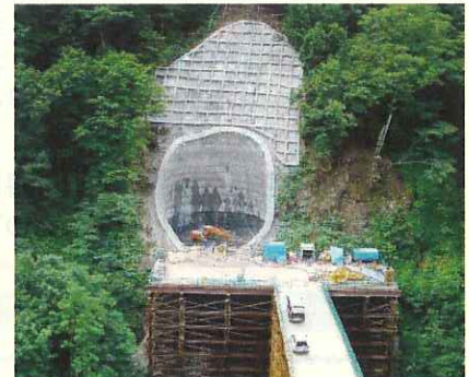
P3竹割り型構造物掘削施工状況
