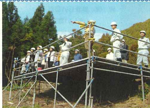
(1号橋下部工 見晴台より 2006.10.18)
