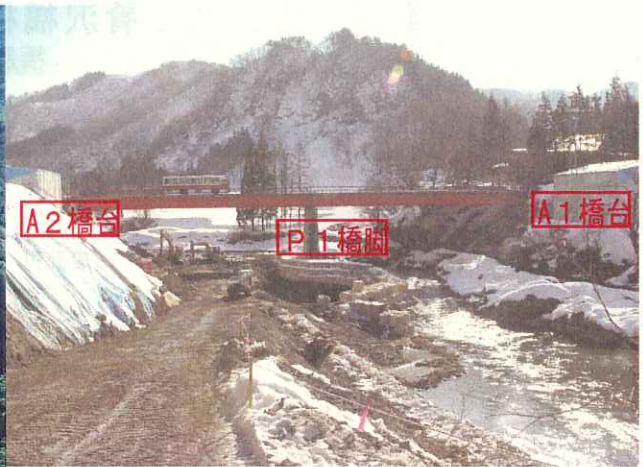
(成瀬川肴沢橋下流から上流を望む)
