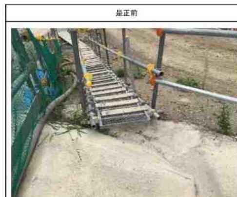
階段と通路の間に段差がある。段差解消が必要。
