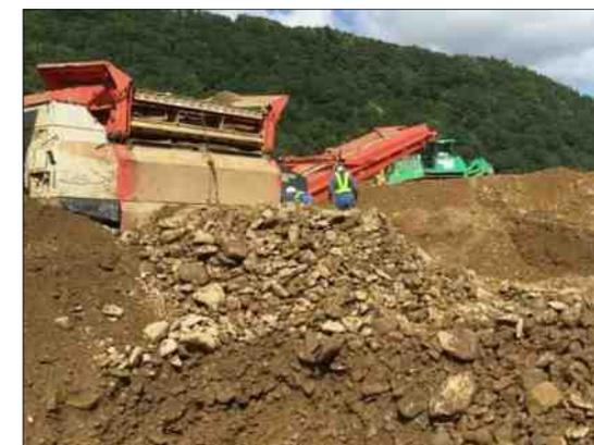
移動式ふるい分け機による応急的な対策
