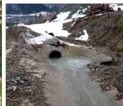
清濁分離工（清水のまま河川へ流下させる導水路）
