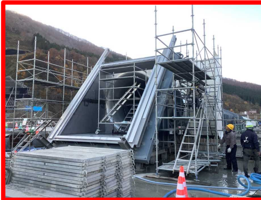
取水設備呑口部施工状況 (R2.11)
