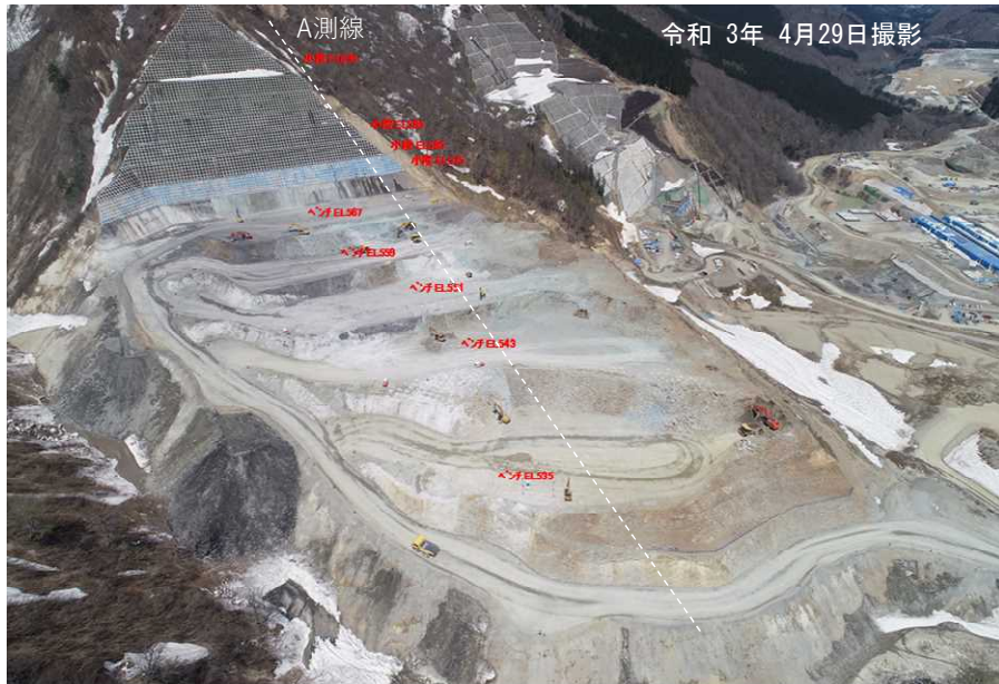
原石山採取工事進捗状況(R3.4月末時点)
