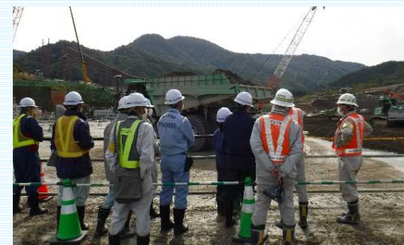
現場視察(CSG打設状況)の様子 (R2.10.9)
