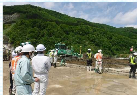
25 現場視察(CSG敷均し状況)の様子 (R3.5.24)
