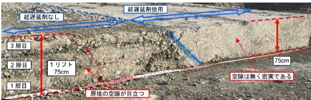
CSG確認試験（実機）（超遅延剤3.0%添加時の効果比較）
