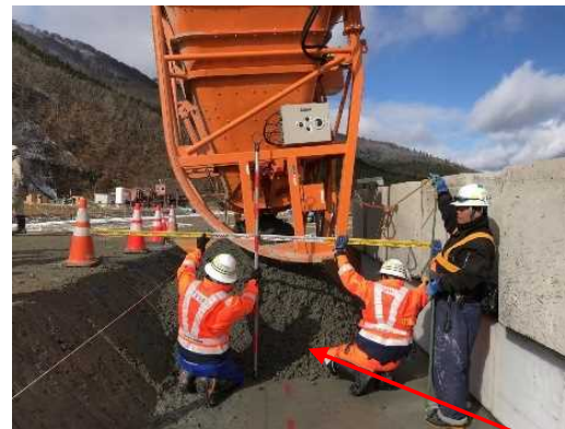
厚さ1.6mの試験施工状況写真
