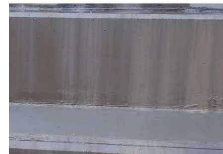
1.6mの打設面の状況
