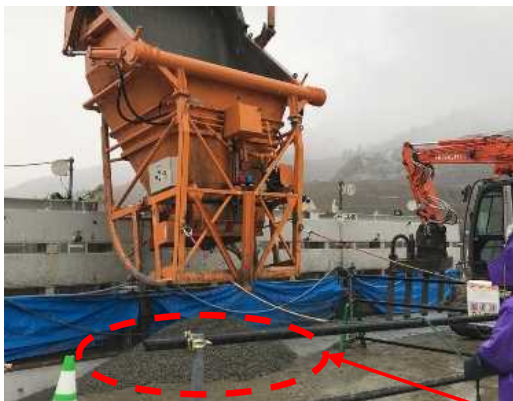
厚さ1.0mの試験施工状況写真
