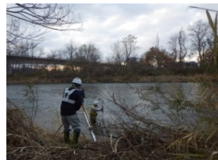
調査状況(横断測量)
