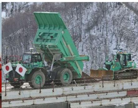
③ダンプ・ブルドーザーによる打設
