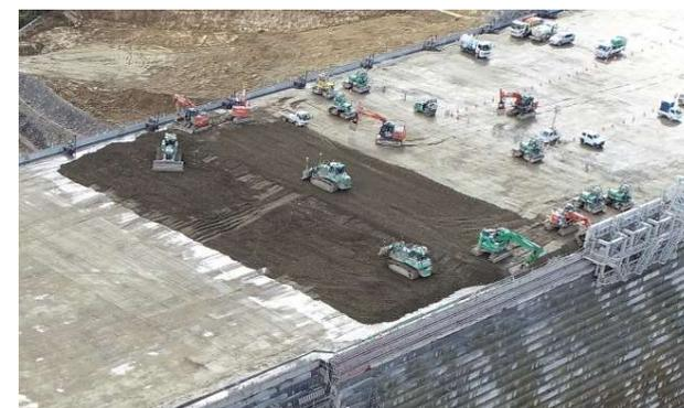
自動化施工による堤体CSG打設
