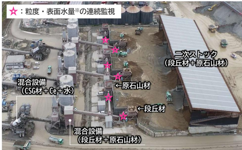
▲成瀬ダムのCSG製造設備（同様の構造を3系統配置）
